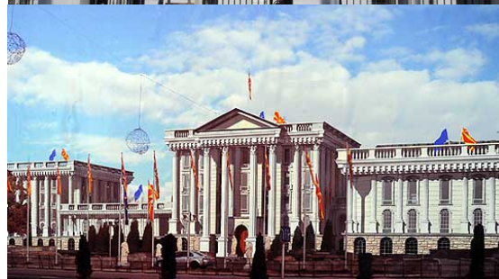
Новиот изглед на зградата на Владата на РМ
